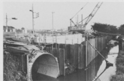
市内あちこちで総合治水対策事業が急ピッチで進められている
