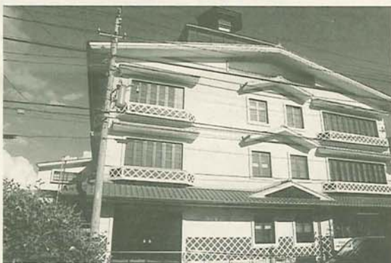
9月にオープンした南部福祉会館(写真)をはじめ、西浦処理場やごみ焼却灰再資源化施設などは、厚生年金・国民年金の積立金還元融資を受けて整備されました。
