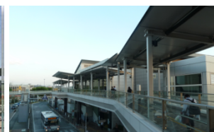
⑦北習志野駅ペDESTリアンデッキ設置事業
