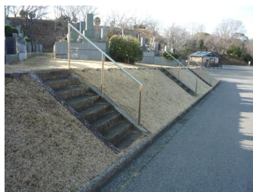
階段に取り付けられた手すり
