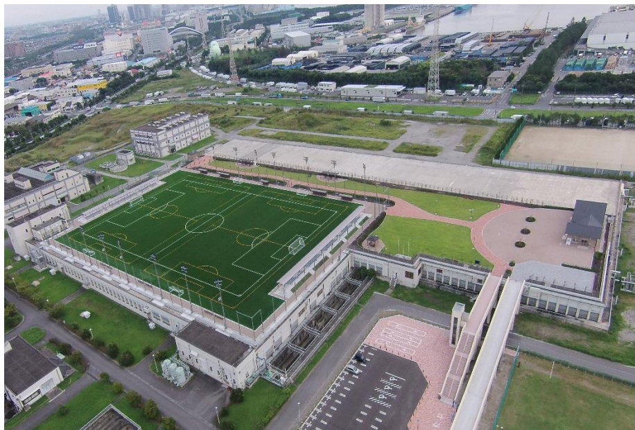
(写真：高瀬下水処理場上部運動広場)
