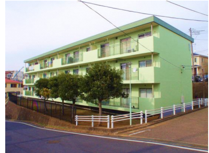
(直営)二宮第一団地：外観
