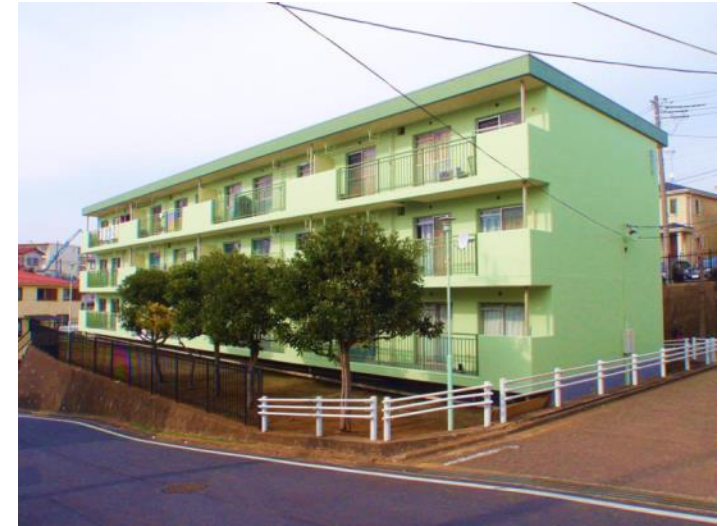
(直営)二宮第一団地：外観
