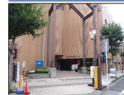
勤労市民センターバリアフリー化等整備事業
