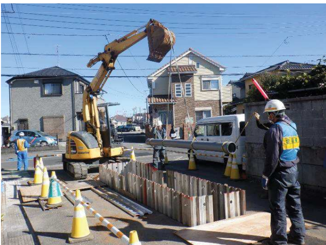
下水道管(汚水)整備状況
