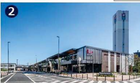
商業施設【B街区】
