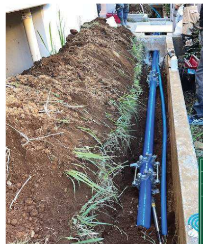
水道用ポリエチレン管の敷設状況
