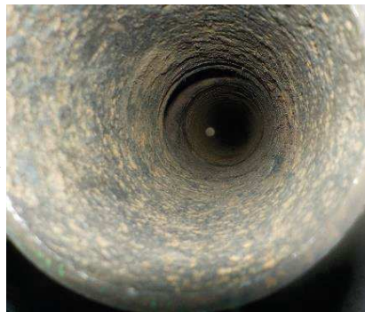
施工中 研磨し平滑になった排水管内面
