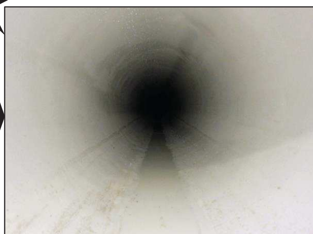
④管更生後
