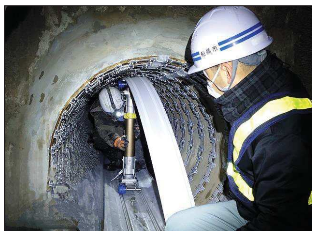
③管更生物業中
