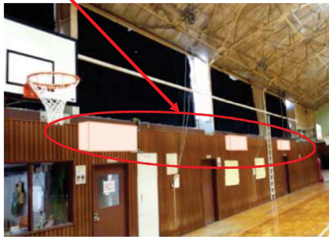
鉄骨造体育館
