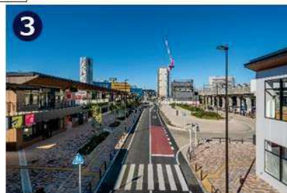
新設道路と駅前広場
