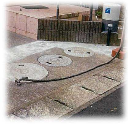
浄化槽転用貯留施設
