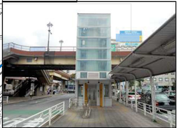
既設エレベーター
