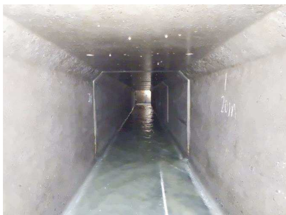
管渠更生(施工前)
