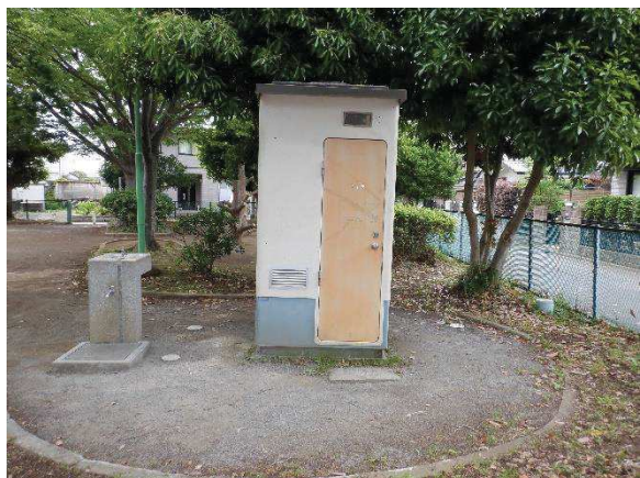
八木が谷第3号公園(現況)
