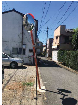
カーブミラーの破損
