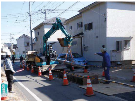
汚水管布設状況
