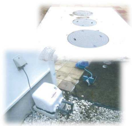
浄化槽転用貯留施設
