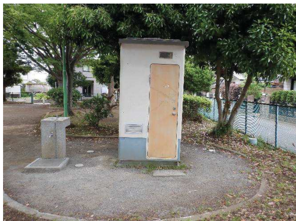
八木が谷第3号公園(現況)
