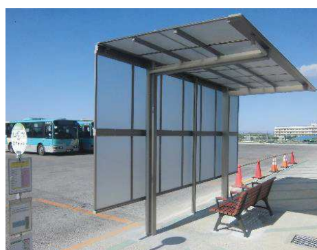
令和3年度整備後(上屋・ベンチ設置)
