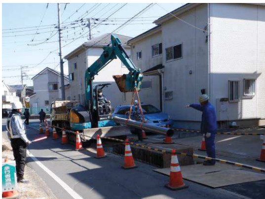
汚水管布設状況
