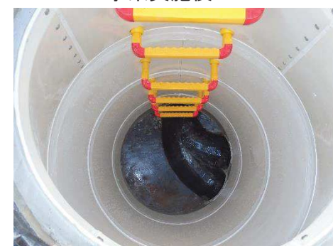
人孔更生(既設人孔内面に新たに人孔を構築)し新品同様となった人孔内部
