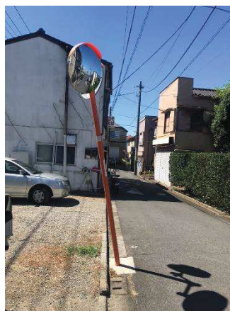
カーブミラーの破損
