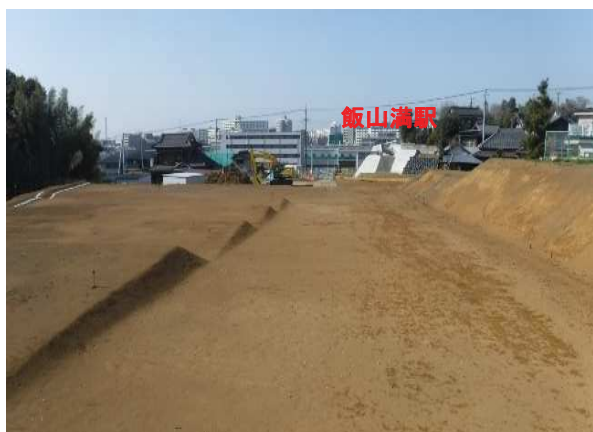
飯山満駅南側整備(現況)
