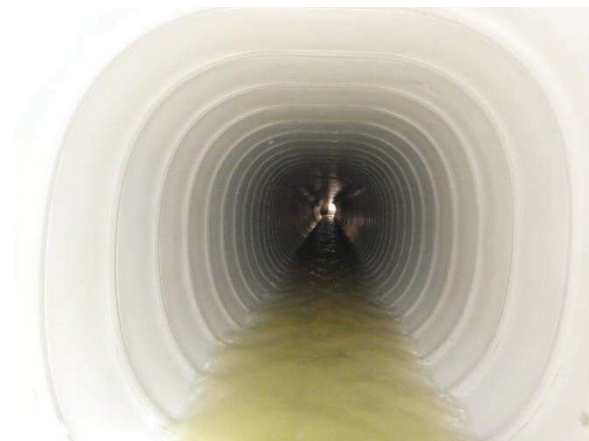
管渠更生(施工後)
