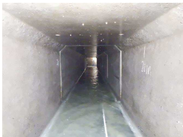
管渠更生(施工前)
