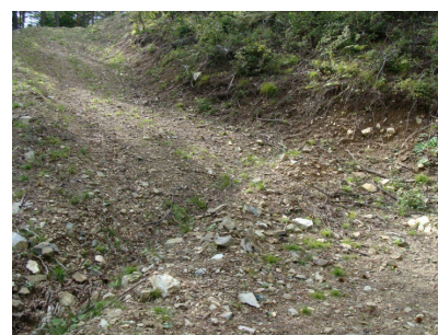
素掘りによる横断溝
