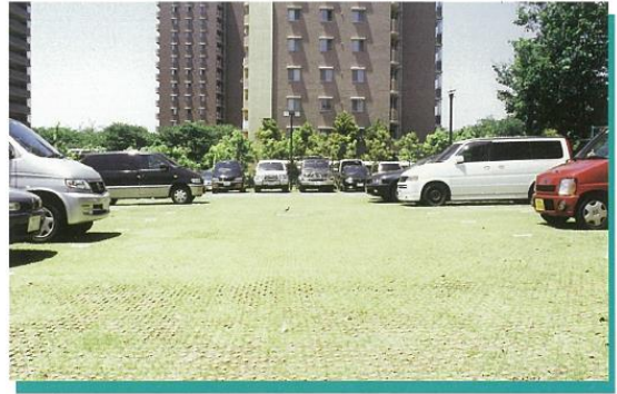
▲駐車場の芝舗装
