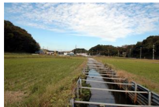
谷津田と斜面林（夏見台）
