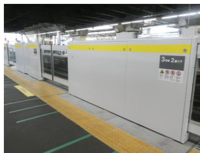
ホームドアの設置
