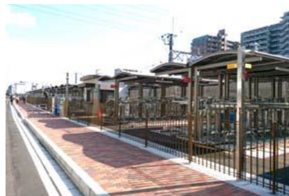
駐輪場の整備
