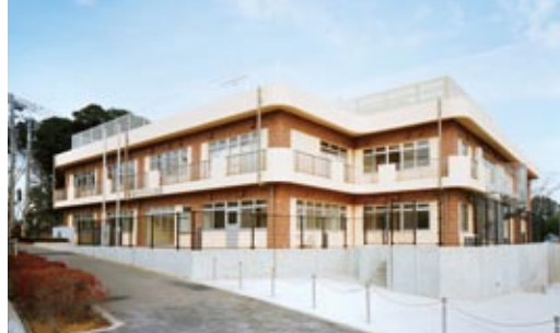
坪井公民館の太陽光発電システム
