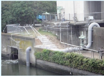
▶西浦下水処理場で実証実験中の小水力発電（最終放流口付近）
