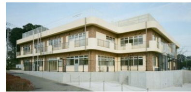
太陽光発電システム（坪井公民館）
