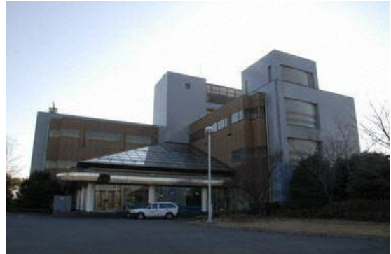
下水汚泥消化ガスの活用 (高瀬下水処理場)
