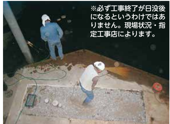
④ 底部に穴開けし、埋め戻します。
