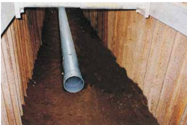
公共汚水ますまでの工事を、船橋市が行います。
