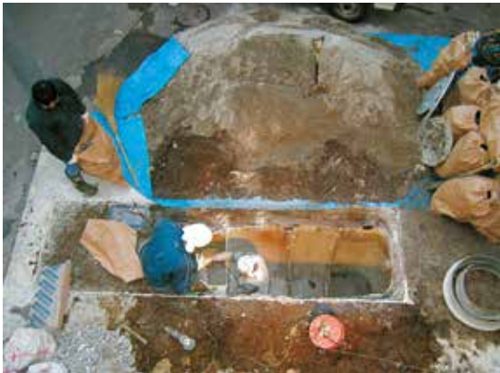
③ 上部を切断し、部材を撤去します。
