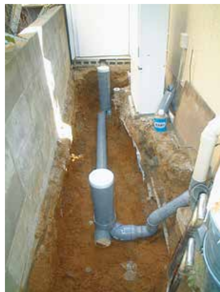
② 勾配を確認しながら配管します。
