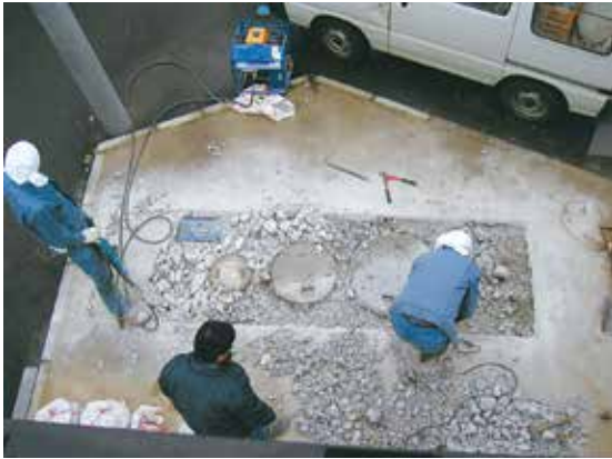
① 浄化槽撤去のはじまりです。
