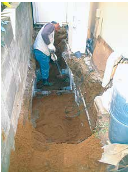
① 穴を掘り配管の準備をします。
