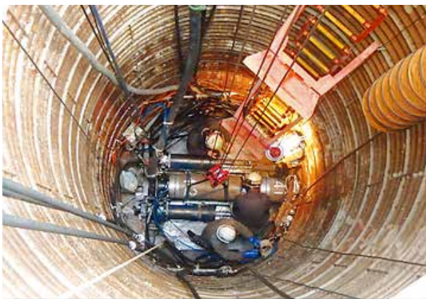
《立坑作業状況》
