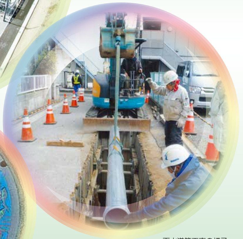
下水道管工事の様子
