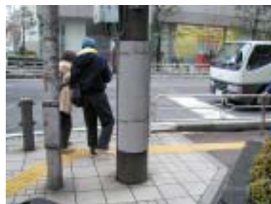
⑨国道14号に曲がる角部の歩道に2本の柱が立っていて、歩道が狭くなっている
