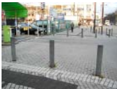
② 駅前広場の駐車場出入口は舗装の色を変えたらどうか
