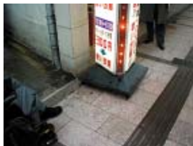
⑥本町通りは景観重視の大型タイル舗装、誘導用ブロックの色が目立たない、断続して看板のはみ出しがあると危険
