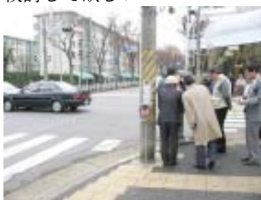
⑪ 歩行者思いやり信号の操作盤のついている電柱が横断歩道の横断部に立っている
