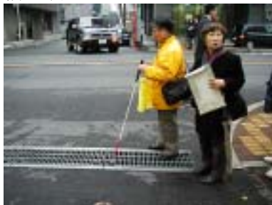
⑩車道との交差部には誘導用ブロックがない、排水のグレータの溝が大きくて杖が引っかかる
