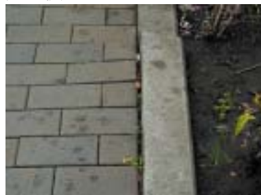
⑫整備済の市役所前通りでも植栽の成長によってタイル目地が広がっているところがある
