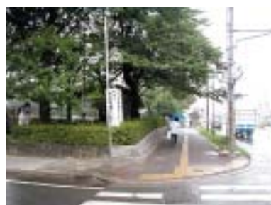
⑫駅前通りは誘導用ブロックが歩道中央に敷設されている
