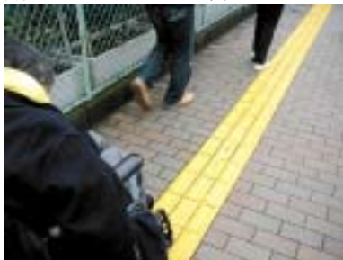
⑪市役所前の通りは誘導用ブロックが分かりやすい、タイル舗装は多少目地の凹凸が目立つ
