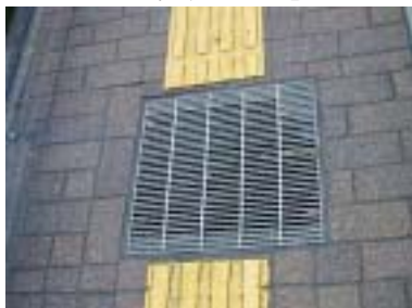
⑪誘導用ブロック上にあるグレーチングの目地が大きい
