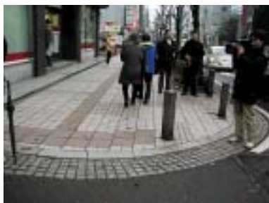
⑧エプロン（排水用ブロック）が景観重視のピンコロ石、誘導用ブロックの色が目立たない
