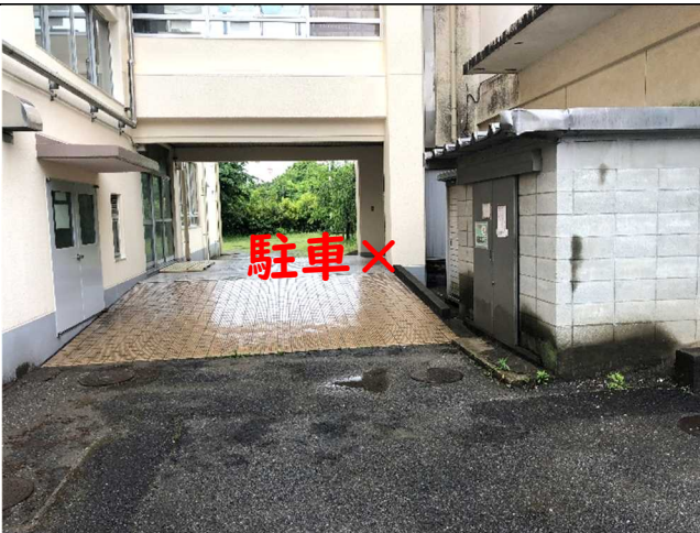
※11 駐車不可 写真 中央は 駐車不可 (グラウンドへの通路と生徒の渡り廊下のため)
