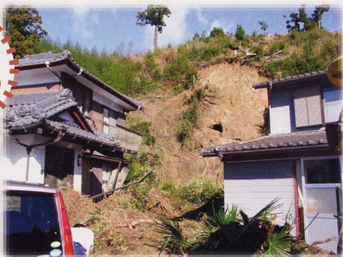
▲斜面が急激に崩れ落ちる
