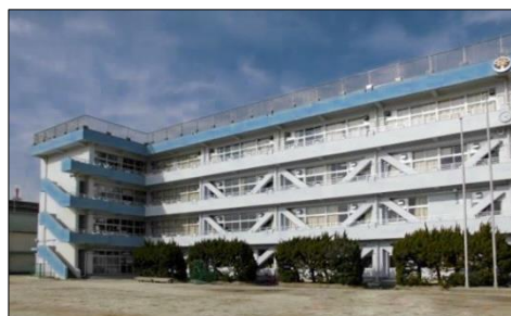
▲ 耐震改修が完了した湊町小学校
